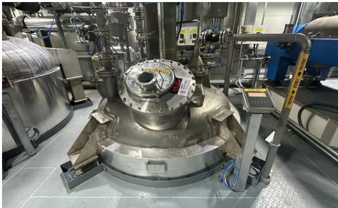
Durch die Funktion Smart Calibration spart Bayer während der Inbetriebnahme mindestens drei Tage.
