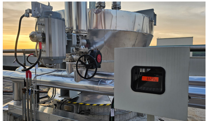
In das DCS-System integrierte Wägeindikatoren X2 ermöglichen die automatische Kontrolle des Be- und Entlastens.
