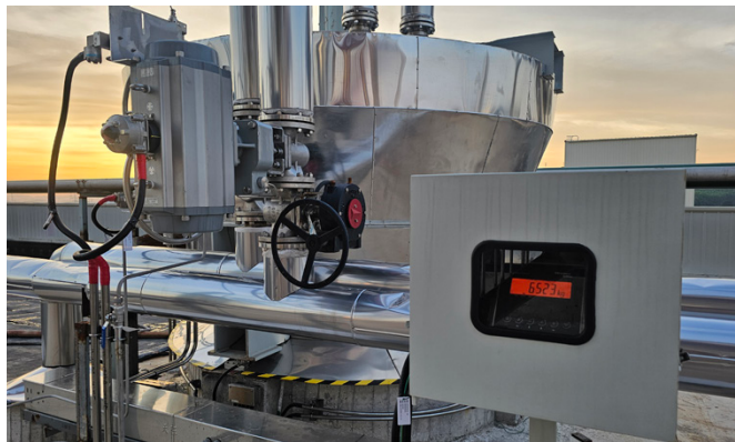
Intégrés au système DCS, les indicateurs de pesage X2 permettent un contrôle automatisé des processus de charge et de décharge.
