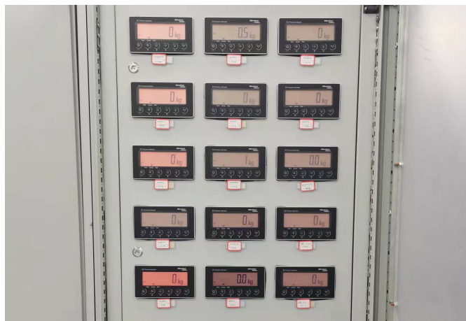
El indicador de proceso X2 del armario muestra de forma fiable los resultados de pesaje.
